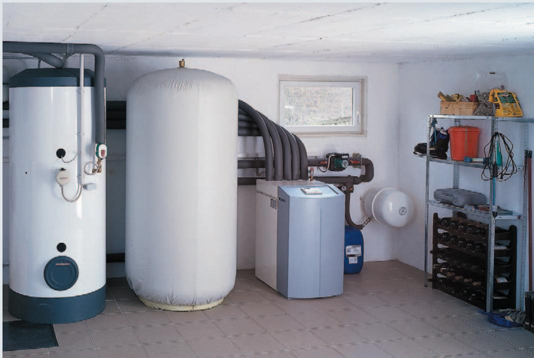
Tepelná čerpadla TTF jsou ideálním přístrojem pro náročnější aplikace. Individuálně dle požadavku objektu a zákazníka lze doplněním o zvláštní příslušenství jako jsou sady pro připojení primárního okruhu systému země/voda (vrty nebo plošné kolektory), akumulační zásobník, zásobník teplé užitkové vody, volit vhodnou konfiguraci soustavy.
